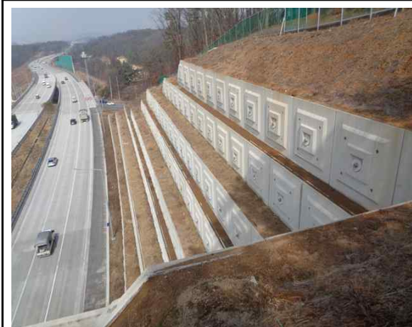
위 치 상부 현 황 전경
