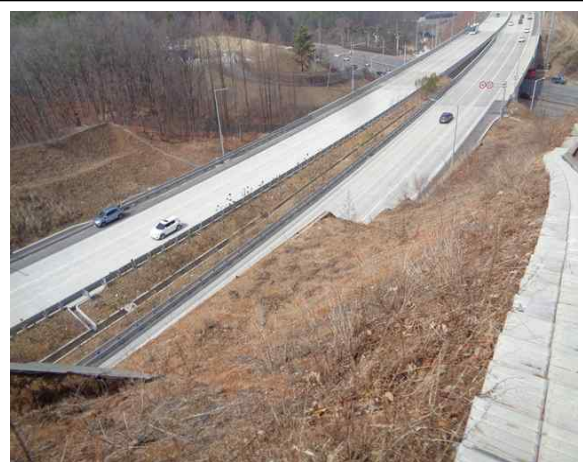
위 치 상부 현 황 전경
